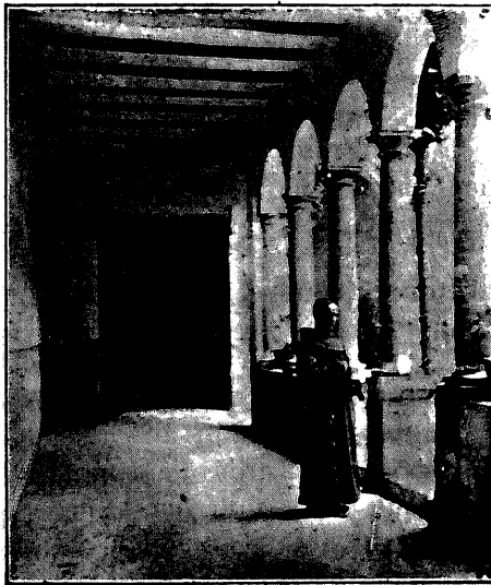
CORREDOR DEL CONVENTO EN LA PLANTA BAJA
