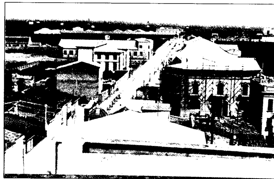
Fig. 2. Fotografia que ens mostra l'edifici en construcció. Arx. Fot. F.F.
