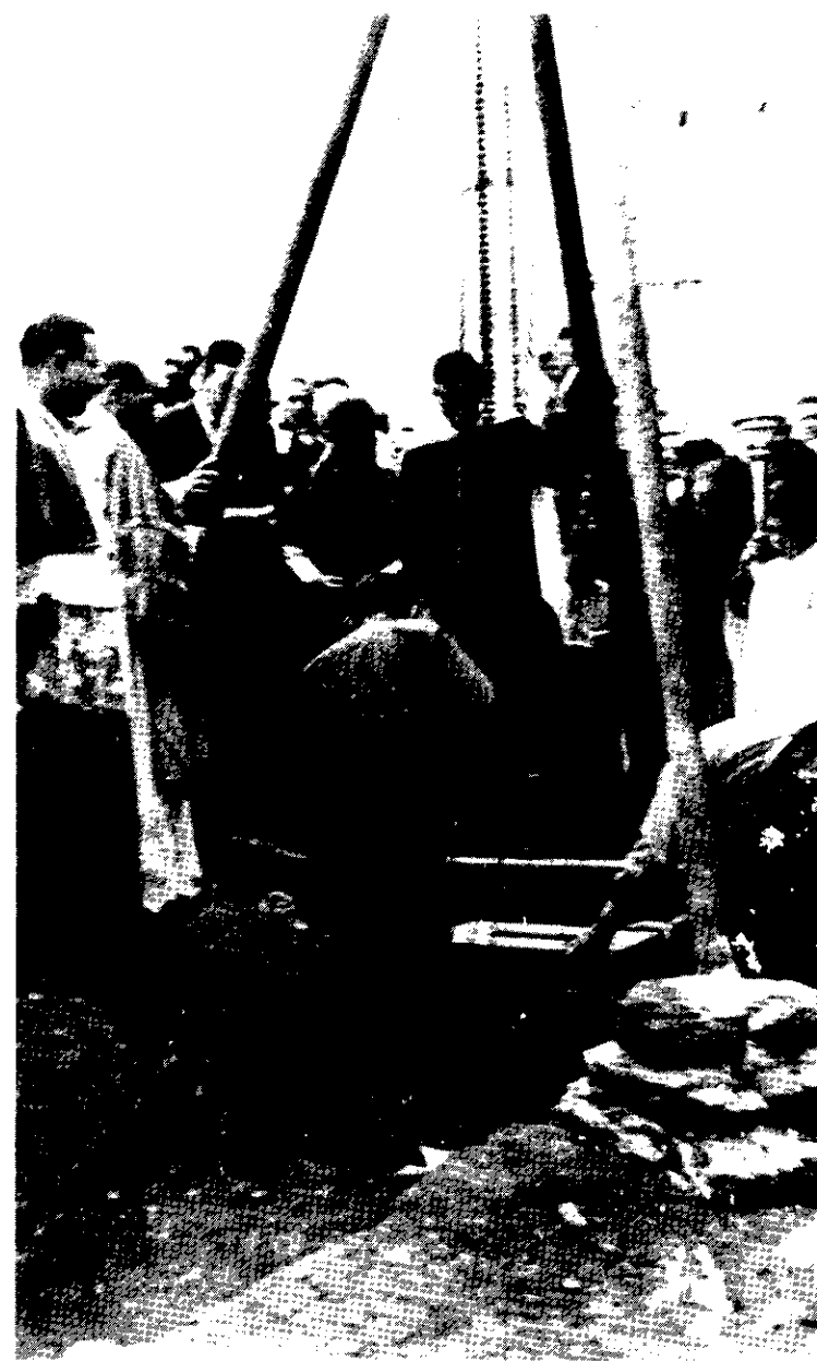
Fig. 12. Col·locació de la primera pedra de la nova capella. 1929. Arx. Fot., F.F.
