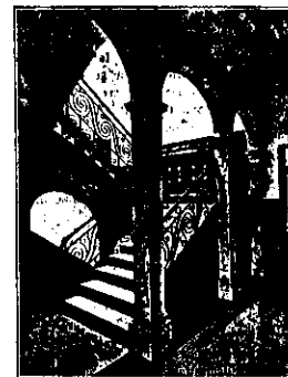
Escuelas nocturnas del Sindicato. Un detalle de la escalera
