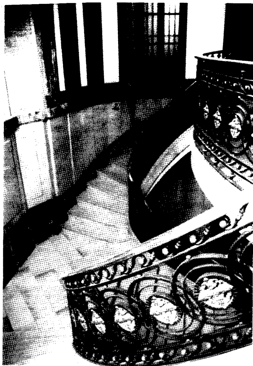
Fig. 24. Detalls de l'escala. Foto Autor.
