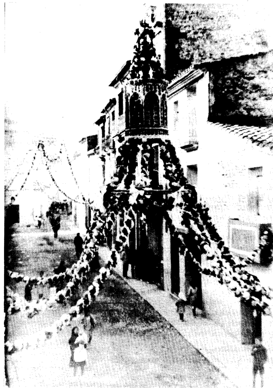
Ornaments al carrer de la Mare de Déu de Gràcia.
