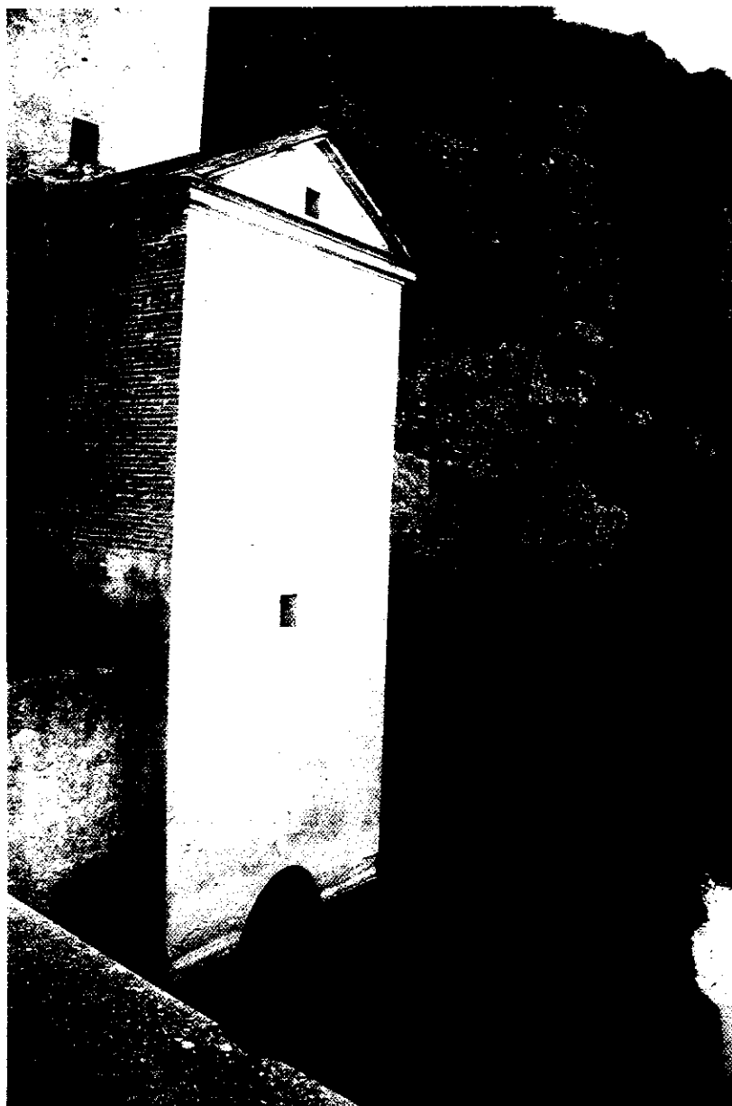
Entrada de agua en la gola de la acequia
